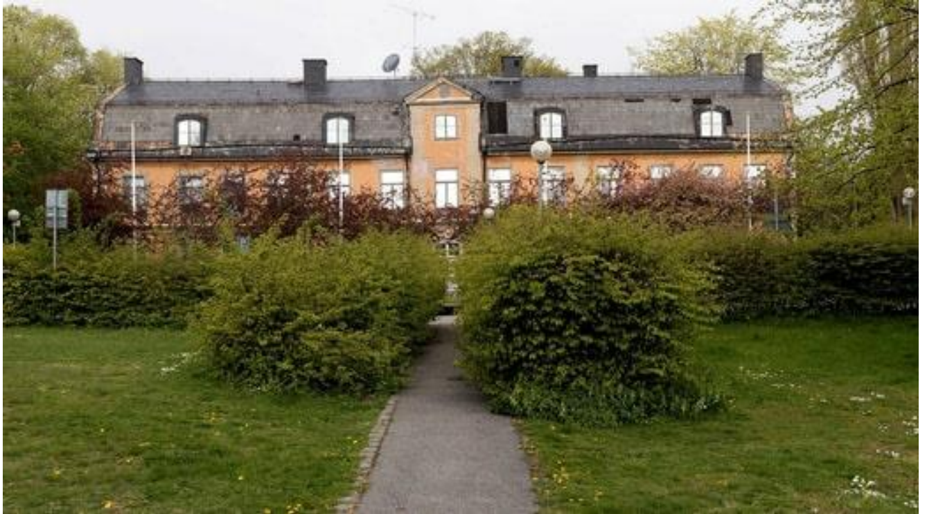
Hovings malmgård vid Barnängen, här finns förslag på flera nya byggrätter. Foto: Lars Epstein
