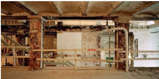
Trapphallen under tidigare renovering
