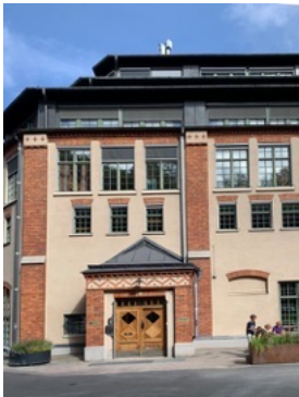
1892, fasadparti uppfört innan 1892
