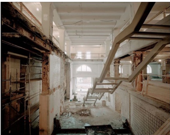
Trapphallen under tidigare renovering
