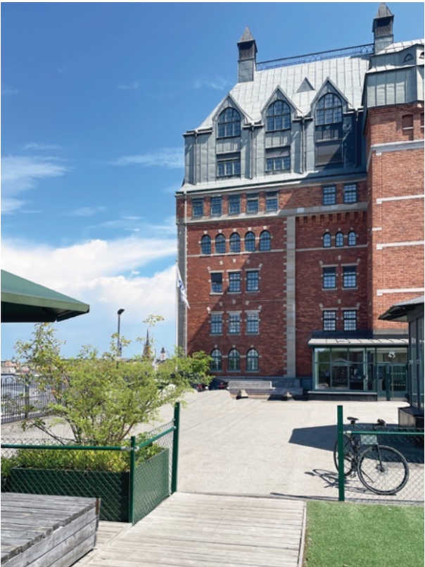
Münchenbryggeriets västra gavel med tillbyggt entréparti.
