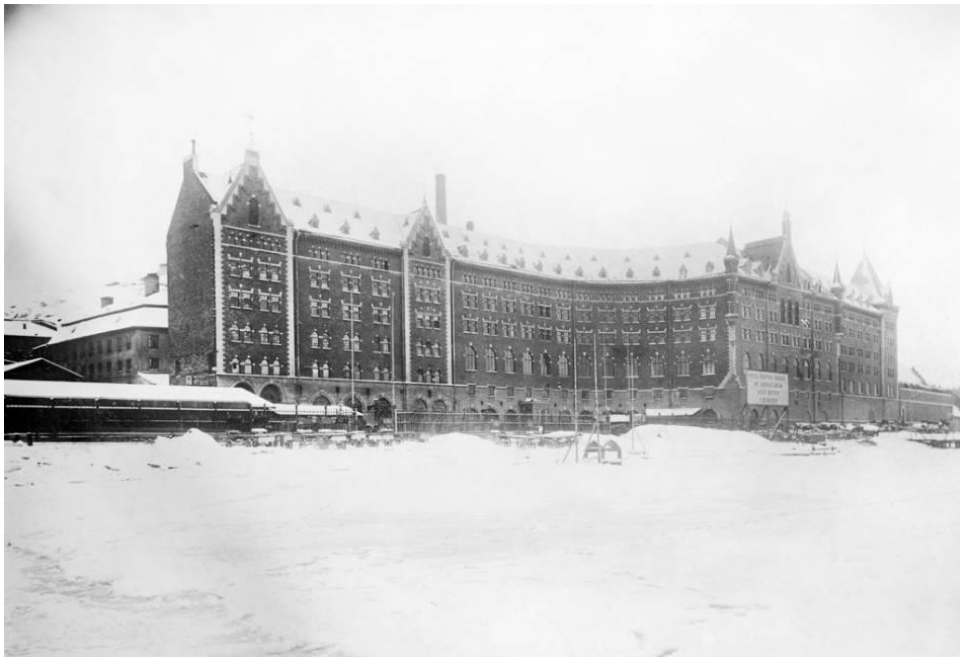
Gammalt. Efter en brand 1893 byggdes bryggeriet om och ut till den byggnad vi i dag är bekanta med. Foto: Fotograf okänd, 1904. Stadsmuseet i Stockholm.
